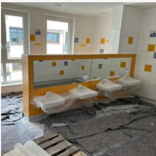
Wie ist der Stand auf der Baustelle Kita Glasbläserallee? Malerarbeiten sind abgeschlossen, die Elektrik in den Wänden, Fußboden wird verlegt, die Bäder sind in Arbeit, und und und
